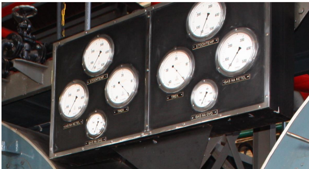
Meterbord met informatie over de trek en de temperaturen van stoom rookgassen
