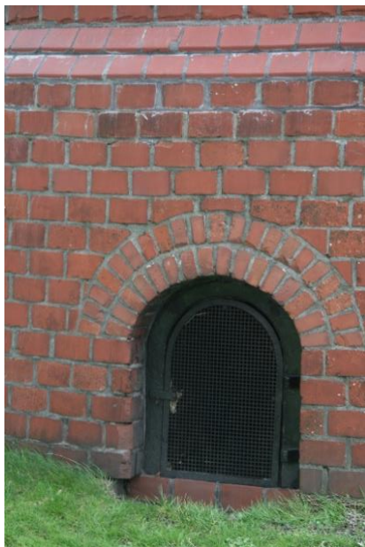
Inspectieluik schoorsteen Woudagemaal
