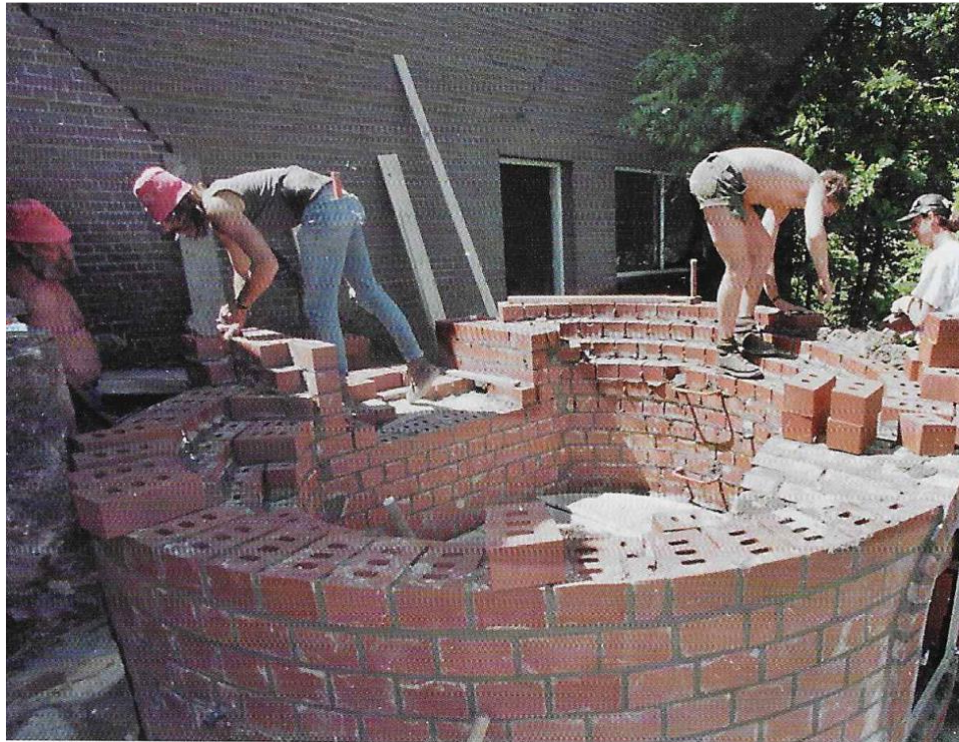
De schoorsteen van het Stoomgemaal De Tuut in aanbouw
