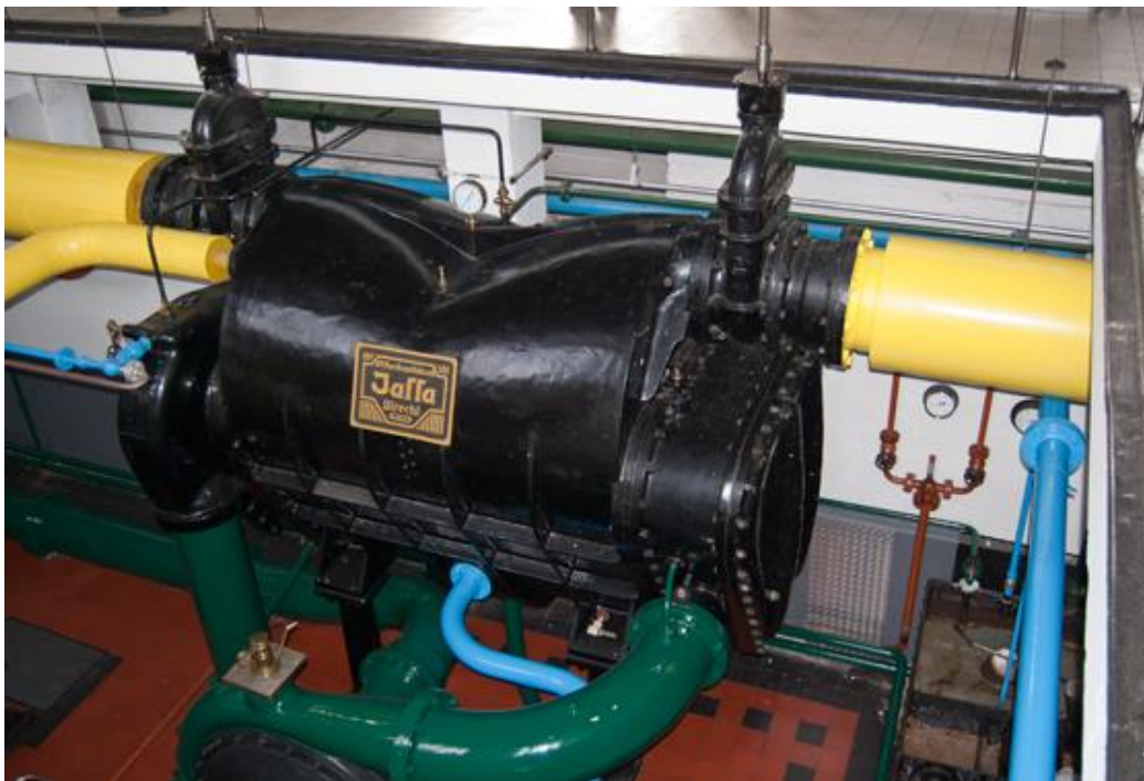
Oppervlaktecondensator in D.F. Woudagemaal
